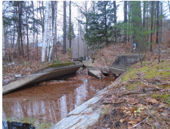
Figure 21 : Ouvrage de trop plein (point de vue de l'entrée du lac Écho vers l'exutoire)
