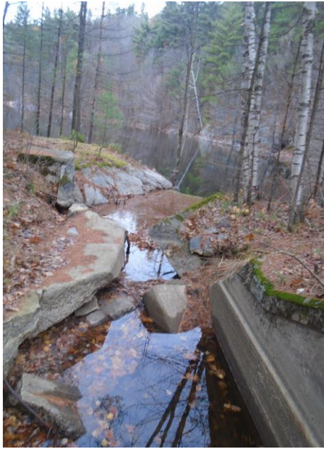
Figure 20 : Ouvrage de trop plein (vue du centre vers la connexion au lac Écho)
