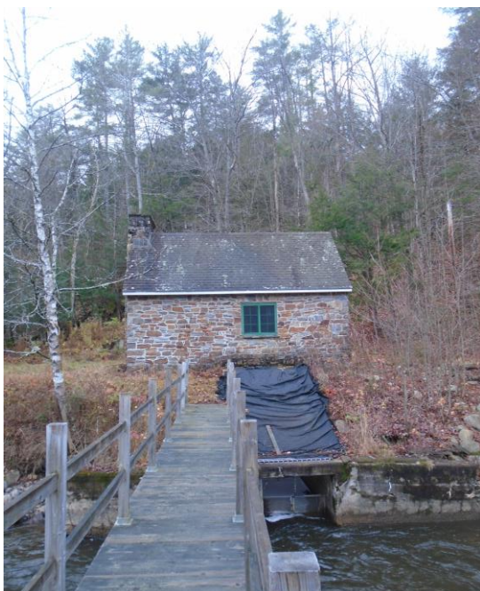
Figure 26 : Extérieur de la station de pompage – Pont et bâtiment de prélèvement
