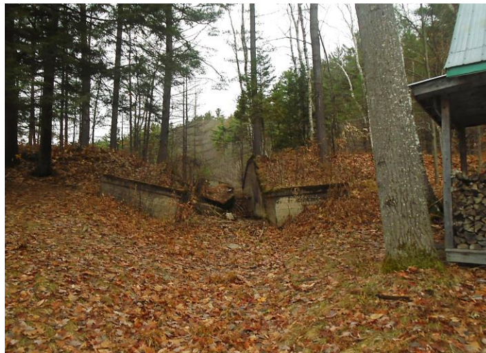
Figure 22 : Exutoire de l'ouvrage de trop plein du lac Écho
