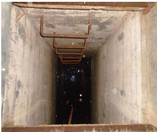
Figure 32 : Trou d'homme sous le bâtiment de la digue du lac Écho
